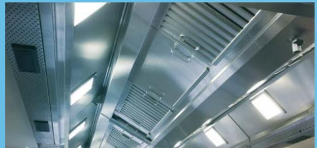
Halton associe aux hottes à jets de captation un système de ventilation par déplacement d'air grâce à des diffuseurs soufflant l'air à très faible vitesse afin de garantir un confort optimum et minimiser les risques de courants d'air.
