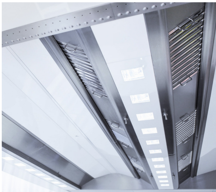
Udsugningskamre med kurver
