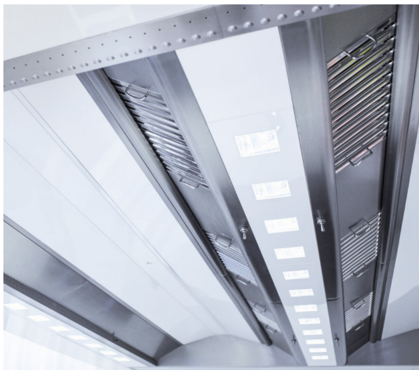
Frånluftskammare med radie
