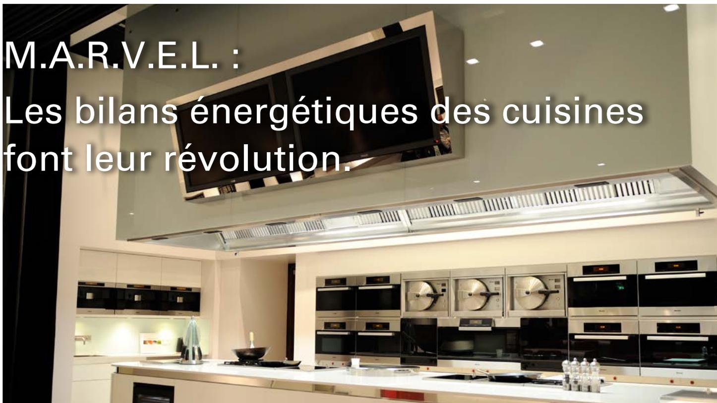
Le système M.A.R.V.E.L.\* est un véritable concentré d'innovations technologiques qui représente la meilleure expression du concept Halton de «Cuisine Haute Performance». C'est le premier système de Contrôle de Ventilation à la Demande (DCV - Demand Control Ventilation) réellement intelligent, réactif, totalement flexible et adapté à la fois aux hottes et aux plafonds filtrants.
