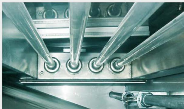
Grâce à la technologie Capture Ray UV-C Halton de destruction des particules de graisse, le contrôle des émissions et l'efficacité de filtration atteignent des niveaux jamais atteints. Les hottes à Jets de Captation peuvent intégrer des dispositifs de lampes UV-C, qui permettent de réduire les fréquences de nettoyage des gaines d'extraction, l'amélioration de l'hygiène et de la sécurité incendie.
